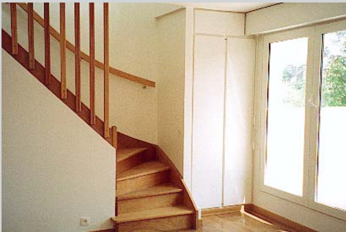
Accès à la terrasse depuis le bureau
