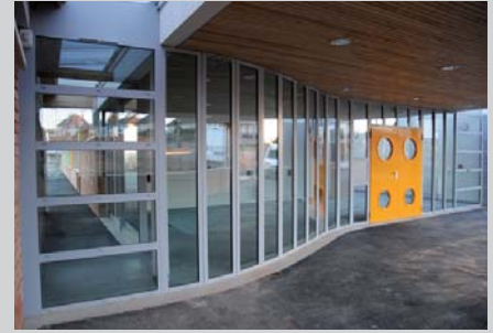
Accueil - façade vitrée
