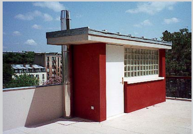
La toiture - terrasse
