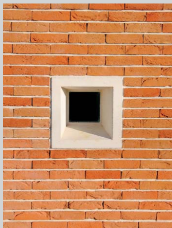
Pavé de verre et calepinage brique
