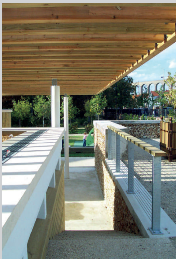
Vue sous la pergola
