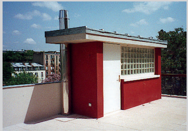
La toiture - terrasse
