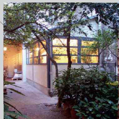
Façade sur cour commune
