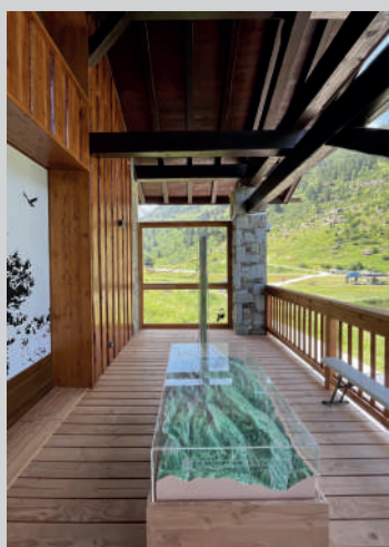
Terrasse bois reconstruite & vitrée
